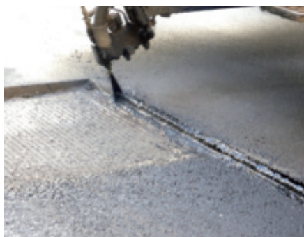
Die Behandlung einer Mittelnaht mit dem SKS Kantenspritzbalken (links). Um einen späteren Wassereintritt in die unteren Schichten zu vermeiden, werden die Flankenflächen vollständig mit Heißbitumen abgedichtet.
