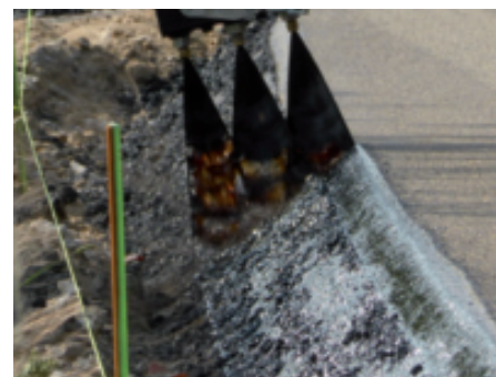
Die Behandlung einer Mittelnaht mit dem SKS Kantenspritzbalken (links). Um einen späteren Wassereintritt in die unteren Schichten zu vermeiden, werden die Flankenflächen vollständig mit Heißbitumen abgedichtet.
