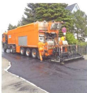
Eine DSK-Verlegemaschine Typ Schäfer SMS 12.000, eingesetzt von Possehl Spezialbau aus Spremlingen.
