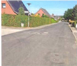
Eine mit DSK-Asphalt sanierte Straße kann bereits nach einer halben Stunde wieder für den Verkehr frei gegeben werden.
