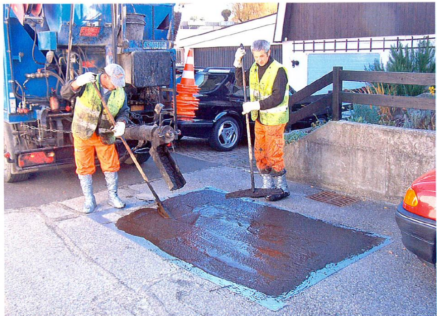
Mit dem Mini-Mix-Verleger kann Kaltasphaltmischgut in klein dosierten Mengen direkt an Ort und Stelle und in hoher Mischqualität für die Straensanierung hergestellt werden.
