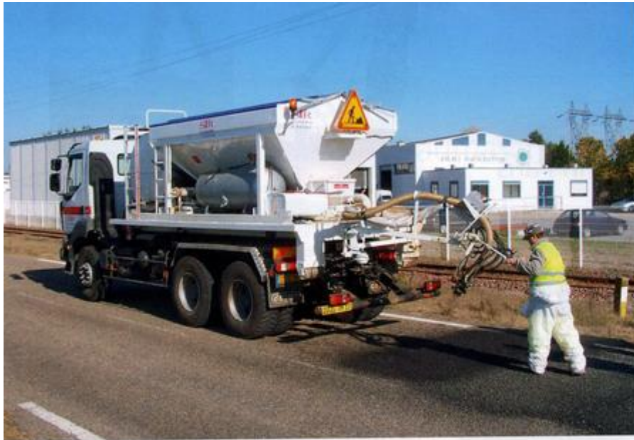
Das Injektionsverfahren (Blow-Patching) im Einsatz in Frankreich.
