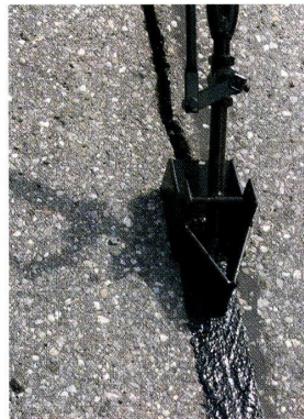
Fugenverguss bei Asphalt.
